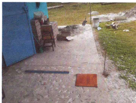
Foto1: Inicio de Instalacion de Piso Ceramico.
