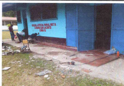
Foto 4: Colocacion de Piso Ceramico en Corredor.
