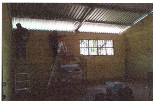
Foto 5: Medición para la Colocación de Cielo Falso.
