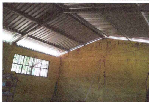
Foto 3: Sustitución de vidrios de las ventanas.
